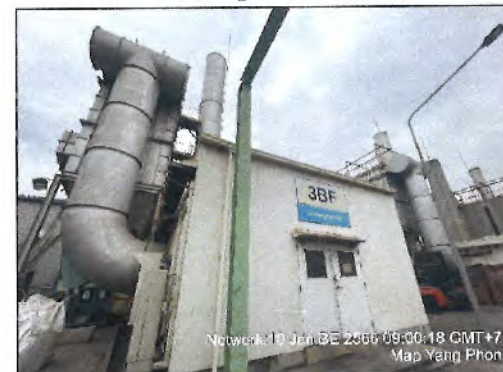
รูปที่ 5 ตัวอย่างระบบ Bag Filter ในกระบวนการนำอลูมิเนียมกลับมาใช้ใหม่
