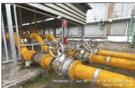
รูปที่ 37 Insulation Joint/Flang
