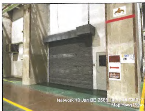
รูปที่ 12 การติดตั้งผนังกันเสียงบริเวณ Chip Crusher และ Blower
