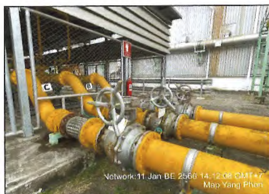
รูปที่ 40 ระบบท่อ By pass และระบบวาล์วสำรองกรณีเกิดความบกพร่องของเส้นท่อหลัก
