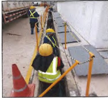
รูปที่ 21 การทำความสะอาดและลอกตะกอนในราง หรือท่อระบายน้ำฝนในพื้นที่โครงการ
