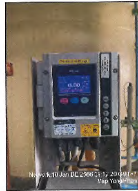
รูปที่ 7 ตัวอย่างระบบตรวจวัดคุณภาพน้ำอัตโนมัติ
