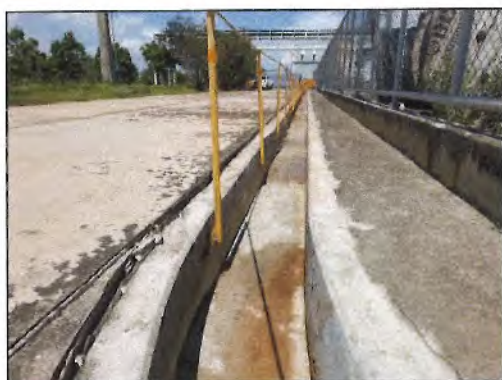
รูปที่ 19 รางระบายน้ำฝนในพื้นที่โครงการ
